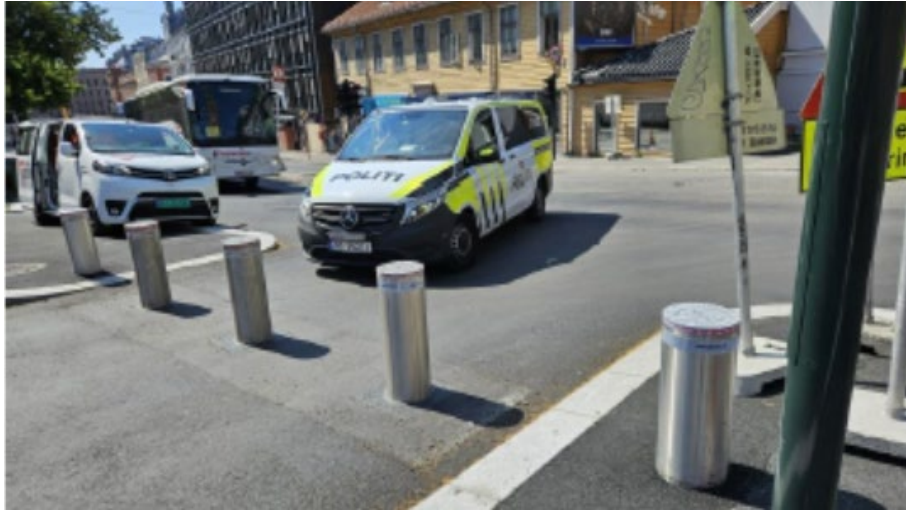
Figur 16: Pullerter i forbindelse med indre og ytre perimetersikring rundt regjeringkvartalet i Oslo. Foto: Swarco
